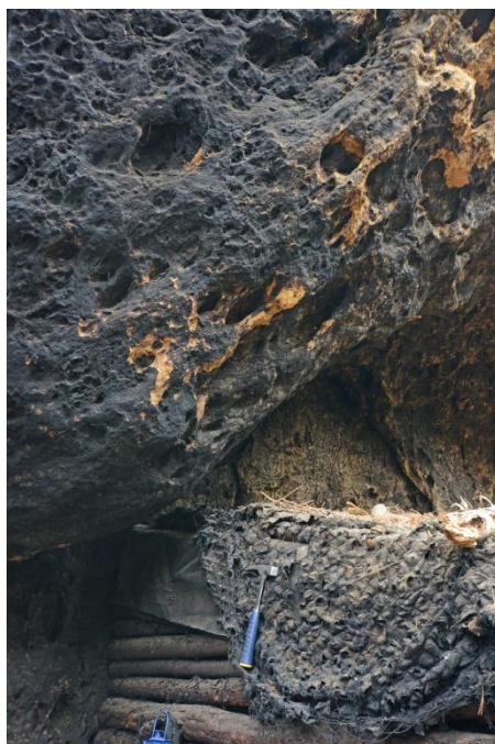
Hvězda 01. Detail lokálního opadu povrchu pískovce na hranách nad srubem (výška 2,7–4 m), zřejmě způsobený zapálením původního srubu v roce 1980.
